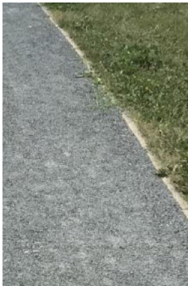
cesta z MZK (mechanicky zpevněné kamenivo)
